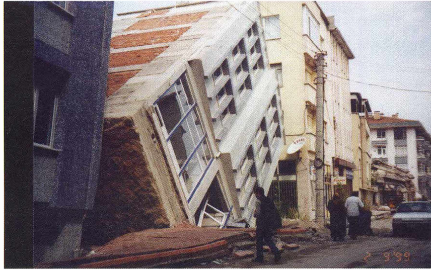
Adapazarı'nda sıvılaşma nedeniyle devrilmiş bir bina
