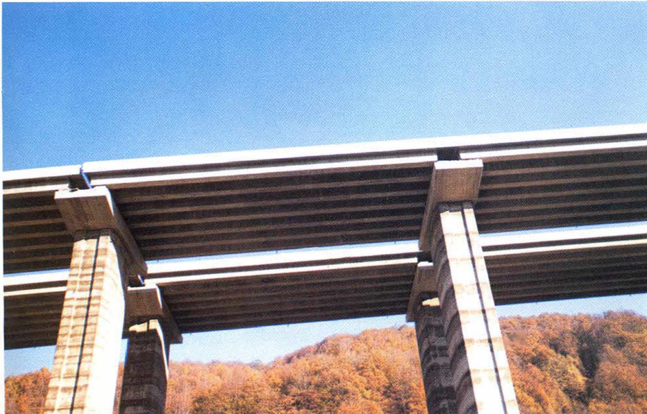
Şekil 16: Viyodük tabliyelerinin batı doğrultusundaki hareketi.
