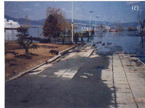
Yanal yayılma hareketine tipik örnekler: (a) Ceyhan Nehri kıyısında (1998) Adana-Ceyhan Depremi ve (b) Sakarya Nehri kıyısında (1999 Kocaeli Depremi) yanal yayılmaya ilişkili şev hareketleri (c) Gölcük-Kavaklı'da denize sürüklenmiş kıyı ve sıvılaşan kum
